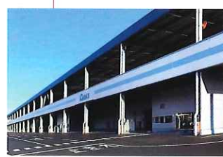
清水(静岡)物流倉庫
