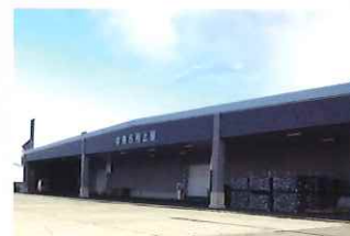
小樽(北海道)物流倉庫
