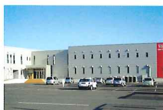
福山(広島)物流倉庫
