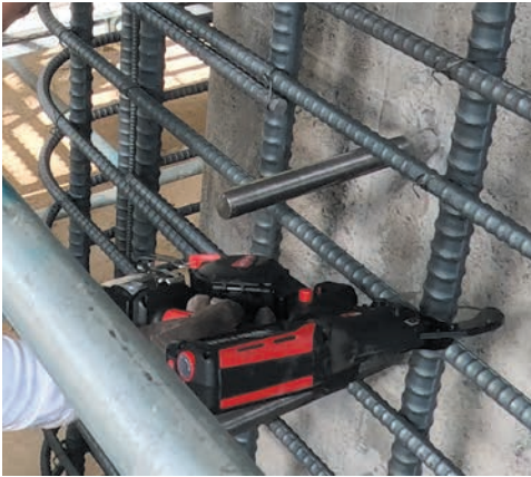
土木工事 橋梁 補強工事 D38×D22
