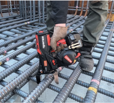
土木工事 橋梁 フーチング D51×D32
