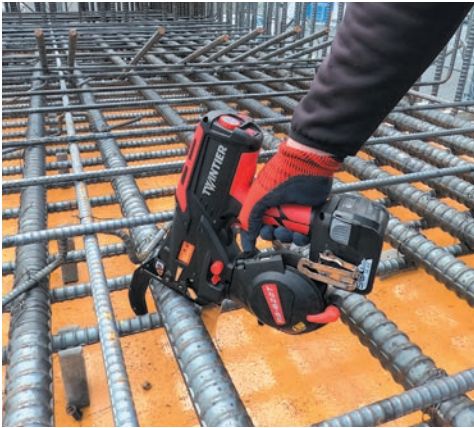
土木工事 橋梁 梁 D51×D25
