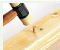
③テーパー錐であけた節穴に接着 剤を塗布した木栓を打ち込み、 突起した部分を切り取りカンナ で仕上げる。
