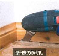
壁・床の際切り
