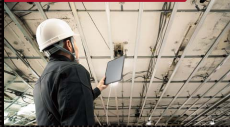
現場調査時にタブレットへ給電
