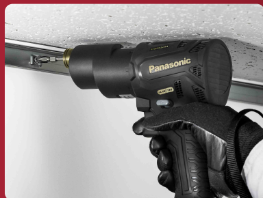
壁際のメタルモールの取り付け
