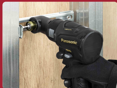
配線支持金具取り付け
