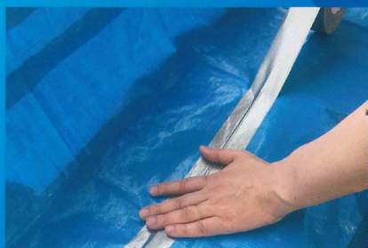
ビニールシート等の繋ぎ
