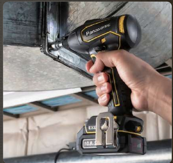
ダクト接続時のボルト締め
