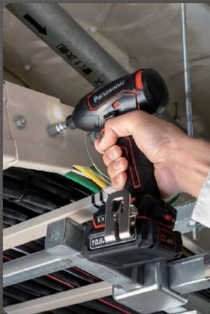
ケーブルラック接続時のボルト締め
