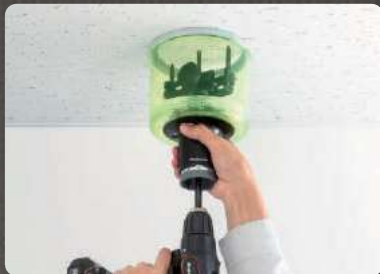
化粧ボードへのダウンライト用穴あけ (Φ100mmユニバーサルホルソー穴あけ)
