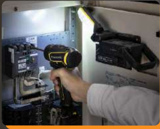
盤内作業に（マグネット取り付け）
