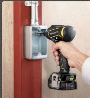
鋼材へのスイッチBOX取り付け
