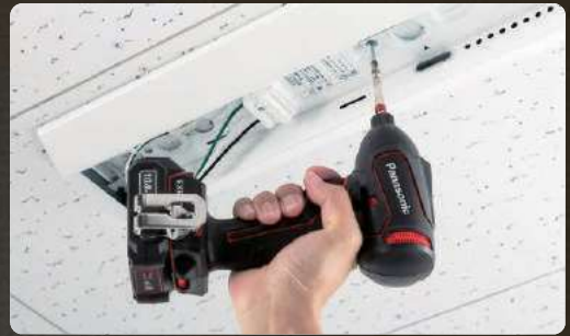
LED照明器具のベース取り付け
