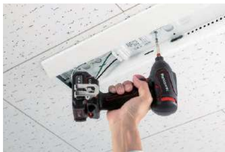
LED照明器具のベース取り付け
