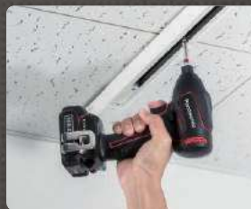
配線ダクトの取り付け
