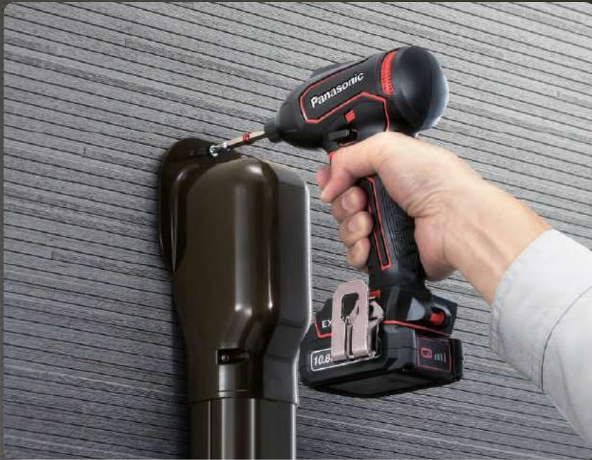
外壁へのエアコンダクト取り付け
