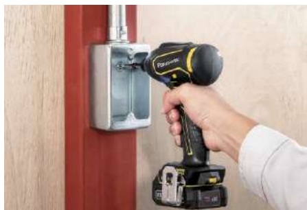
鋼材へのスイッチBOX取り付け
