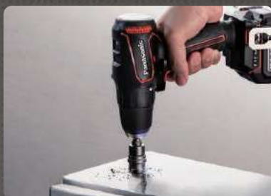
電線管通し用の金工穴あけ (Φ21mm金工ホルソー穴あけ)
