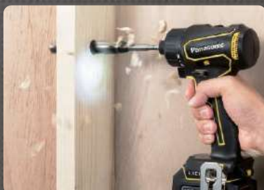
通線用の間柱への穴あけ (Φ18mm木工キリ穴あけ)
