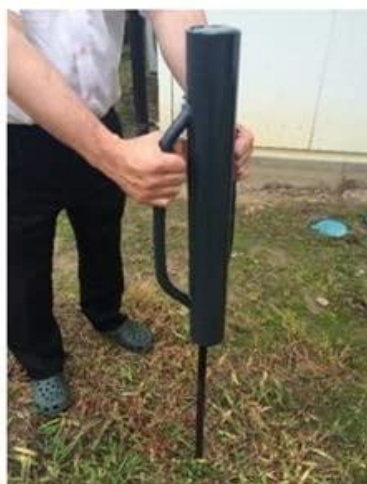
施工イメージ
